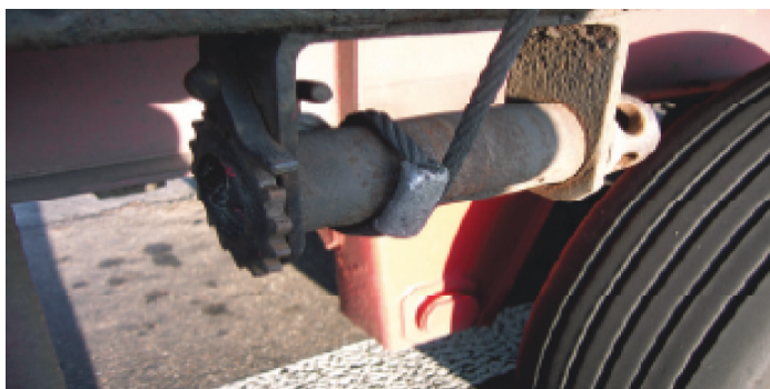
Figur 24: Stålwire spændt med spil
